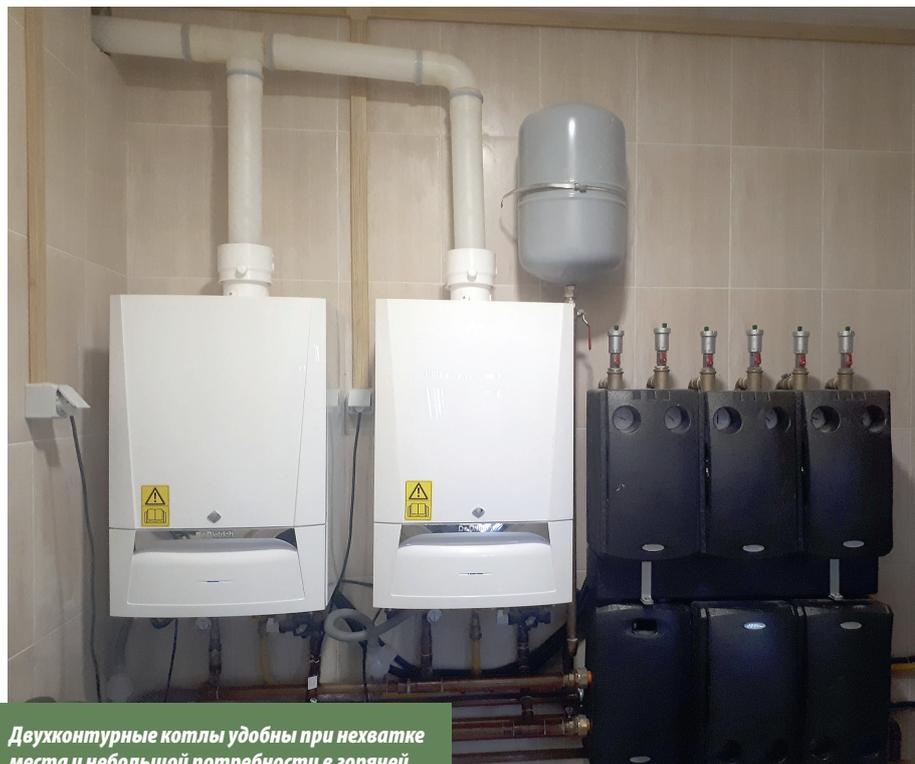
**Двухконтурные котлы удобны при нехватке места и небольшой потребности в горячей воде. В доме с несколькими точками водоразбора лучше использовать котёл или каскад с внешним бойлером большого объёма — чтобы всем пользователям гарантированно хватало горячей воды. На фото: Evodens**
