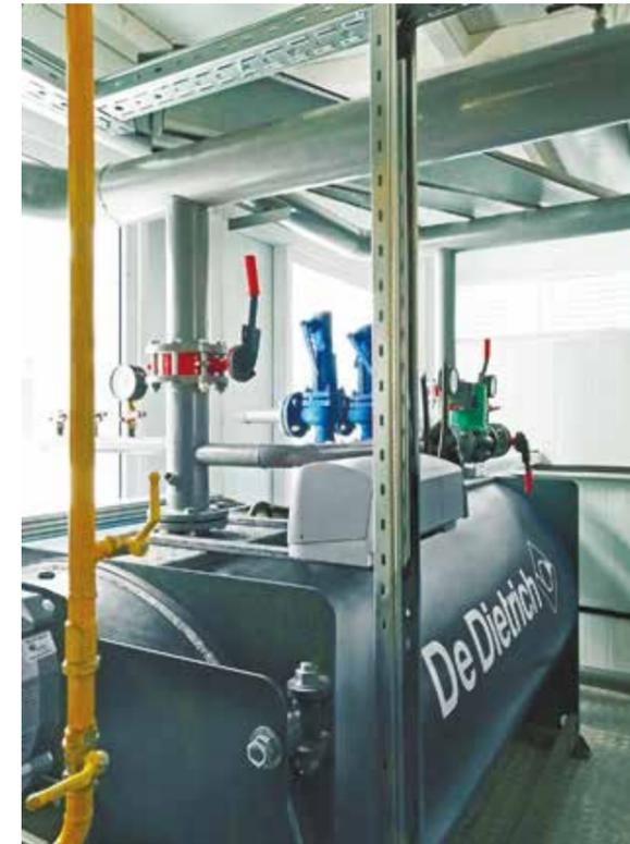
между подающей и обратной линией) до 40 °С, что позволяет работать в конденсационном эффективном режиме даже с высокими температурами в подающей линии. Заданная в настройках ΔТ может поддерживаться автоматически с помощью модулирующего насоса, управляемого от котловой автоматики.
