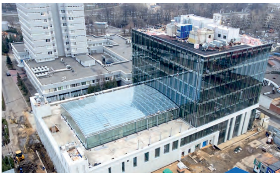
● ● Крышная котельная De Dietrich
