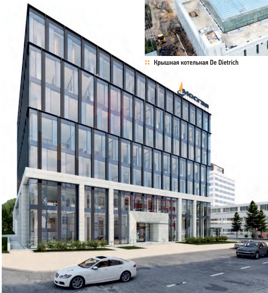
● ● Новый инженерный центр ОАО «Мосгаз» успешно снабжается тепловой энергией
